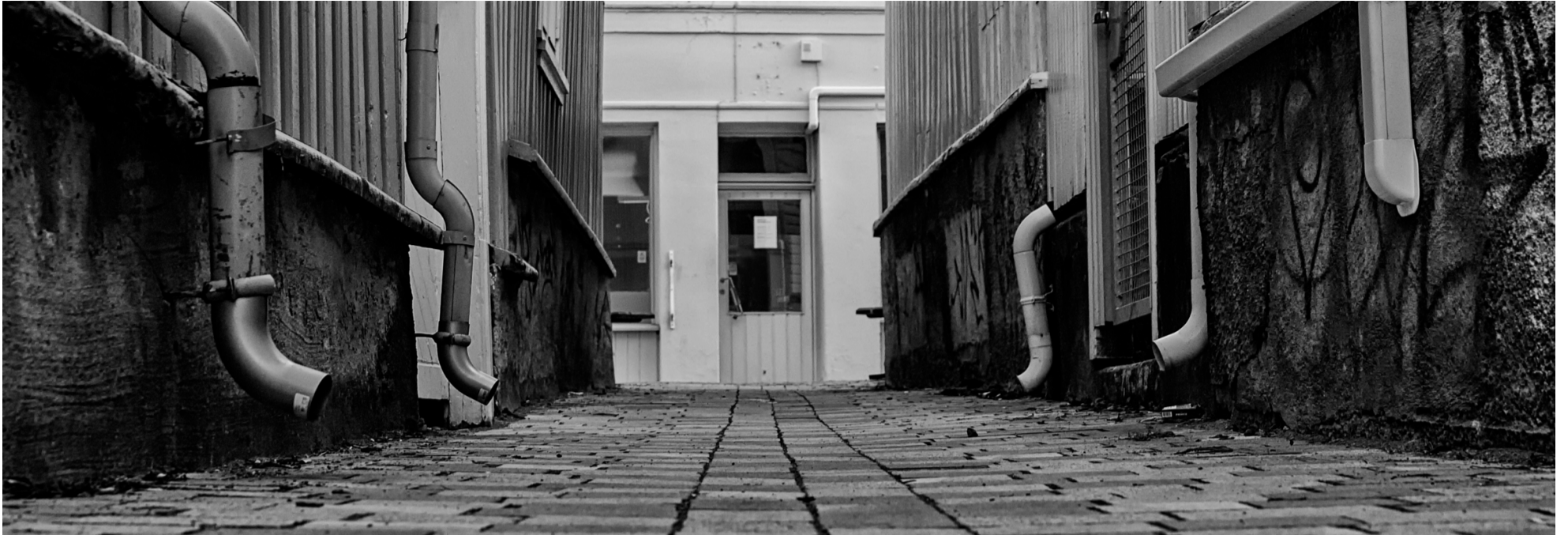
Rainpipes Foto: Harm Kroon
